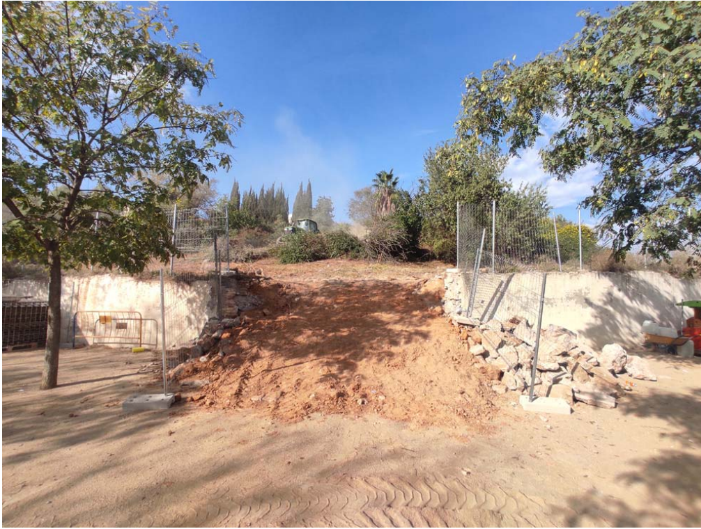
FOTOGRAFIA 3 → Imatge inicial del solar, abans dels moviments de terres, des del sud, un cop obert l'accés al mur perimetral inferior de l'antiga presó de Dones de la Trinitat.
