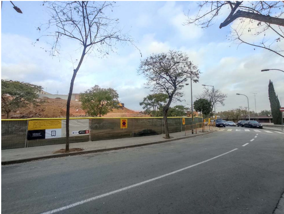
FOTOGRAFIA 1 → Fotografia de la situació de la intervenció arqueològica amb entrada pel carrer del Pare Pérez del Pulgar, 76-90, des del sud-est.
