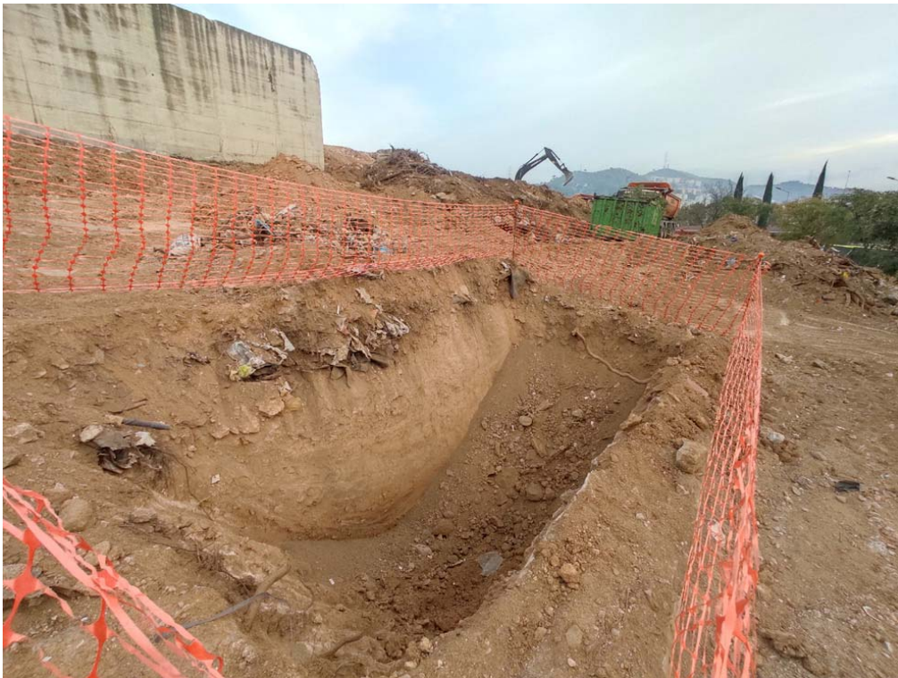
FOTOGRAFIA 10 → Imatge d'una de les cales de sondatge excavades durant els primers dies, en concret a la zona oest del solar, des del sud-oest.
