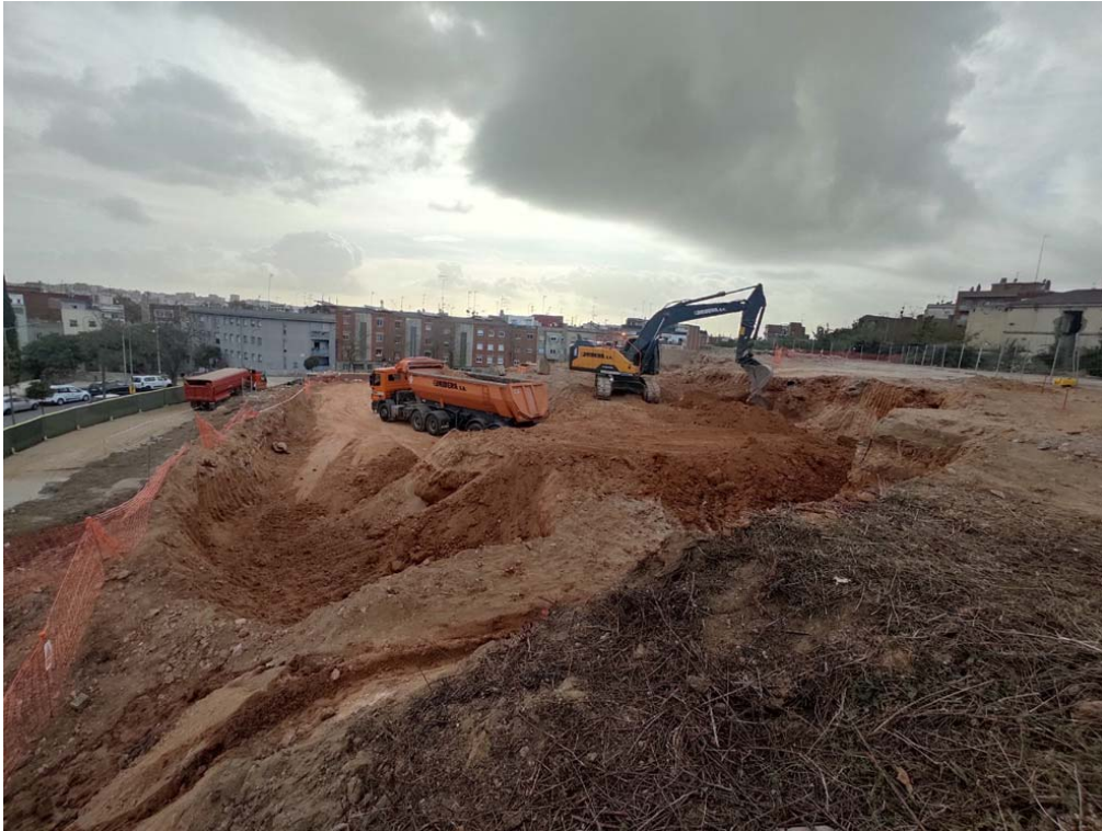
FOTOGRAFIA 24 → Una altra fotografia de la màquina excavadora, excavant el rebaix definitiu a la zona superior nord-est del la parcel·la, des de l'est.
