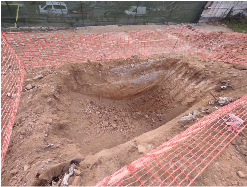
FOTOGRAFIA 11 → Una altra fotografia d'una altra cala de sondatge de comprovació del terreny, oberta a la zona nord-est dels terrenys, des del nord.
