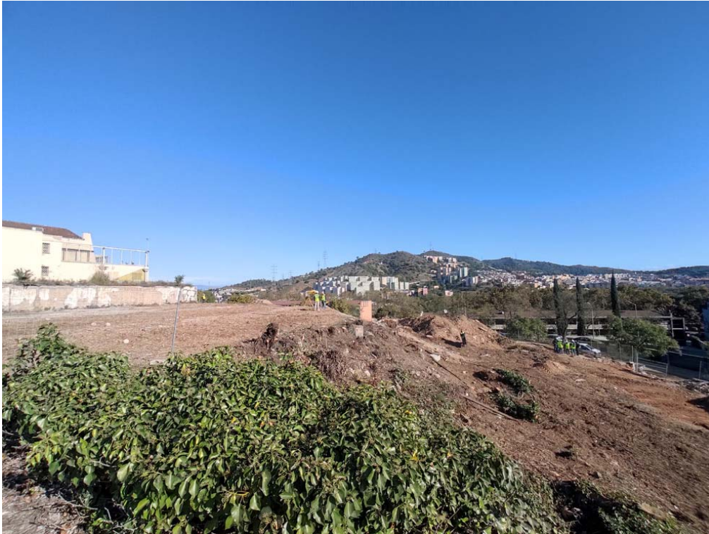
FOTOGRAFIA 7 → Fotografia inicial dels terrenys, durant les tasques inicials de desbrossat i neteja, previs als moviments de terres, des del sud-oest.
