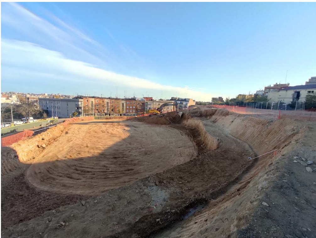
FOTOGRAFIA 27 → Una altra fotografia panoràmica de la parcel·la, des de l'est, on observem la màquina acabant els rebaixos definitius a la banda sud-oest inferior.
