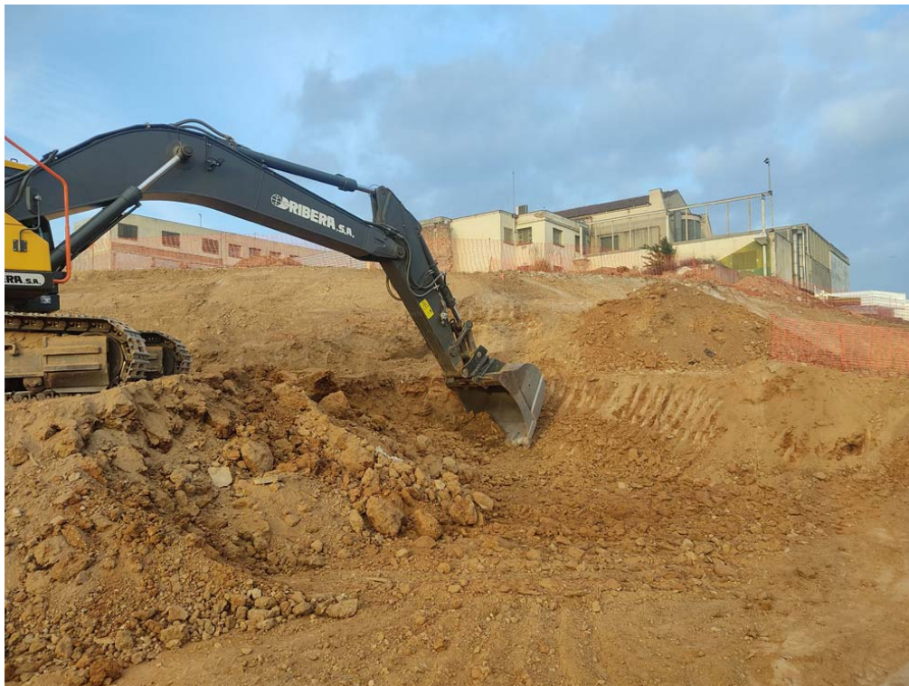
FOTOGRAFIA 18 → Fotografia dels primers rebaixos del terreny, a la vessant sud, després del desbrossat i neteja, des del sud-oest.
