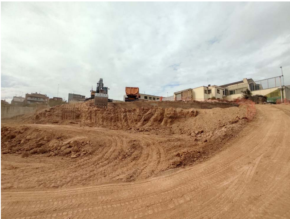
FOTOGRAFIA 23 → Imatge panoràmica de la màquina excavadora realitzant els rebaixos del terreny a la part superior de la parcel·la, des del sud.
