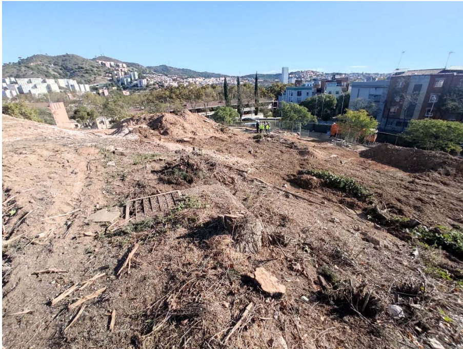
Imatge de les tasques de desbrossat i neteja dels terrenys, abans de començar els moviments de terres, des del sud-oest. (Foto: Òscar Matas).
