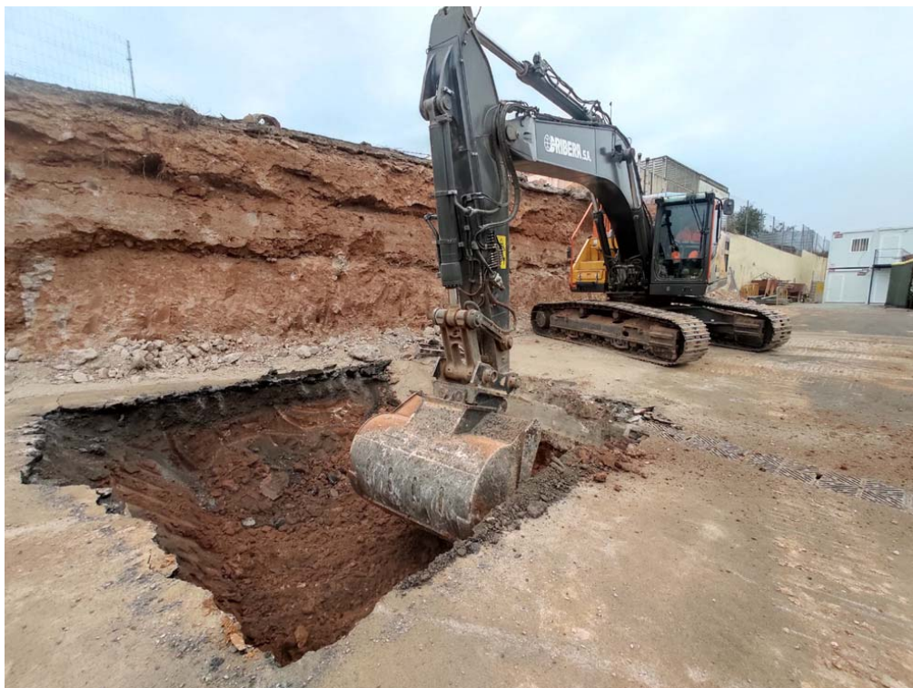
FOTOGRAFIA 21 → Fotografia de la màquina excavadora, obrint el forat per la instal·lació de la grua de l'obra, a la zona inferior est de la parcel·la, des del sud-est.
