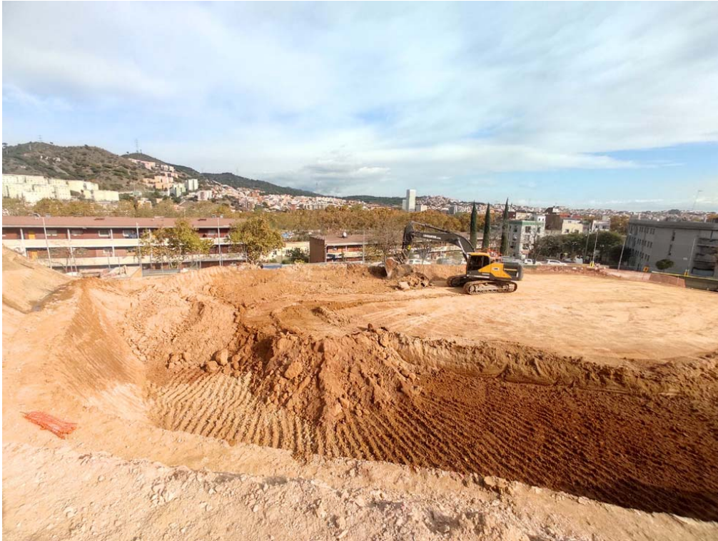
FOTOGRAFIA 26 → Imatge panoràmica de la màquina excavadora acabant els rebaixos del terreny a la part inferior de la parcel·la, des del nord.
