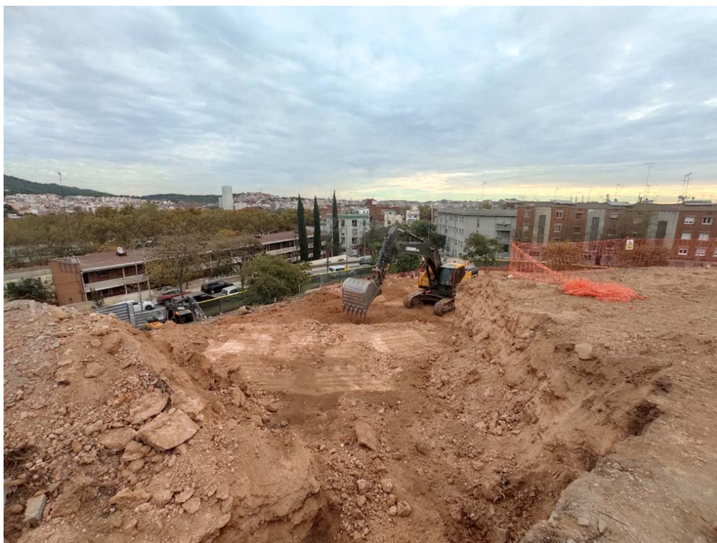
FOTOGRAFIA 19 → Vista panoràmica dels primers rebaixos del terreny, a la part superior est, des del nord-est.
