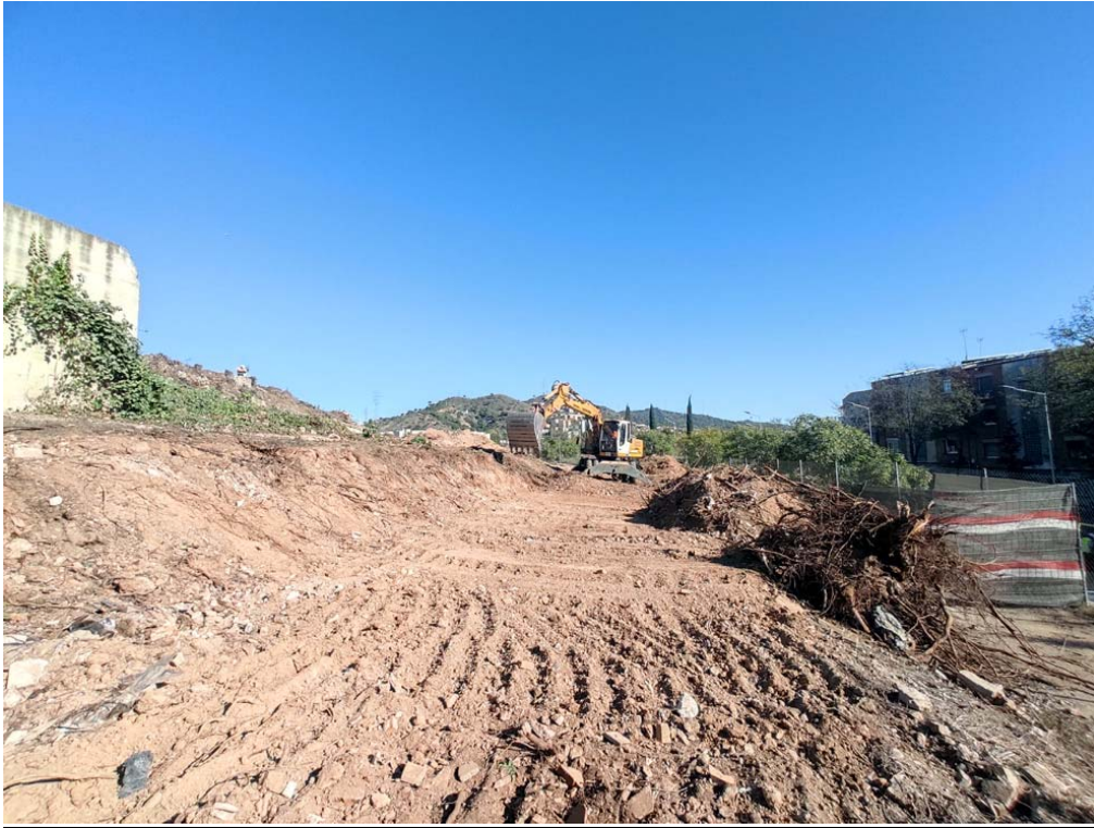
FOTOGRAFIA 9 → Panoràmica de la màquina giratòria efectuant els primers moviments de neteja de les capes superficials dels terrenys des de l'oest.
