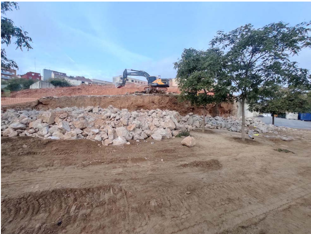
FOTOGRAFIA 14 → Imatge panoràmica de la zona central del mur perimetral inferior de l'antiga presó (UE103), ja demolit, des del sud.
