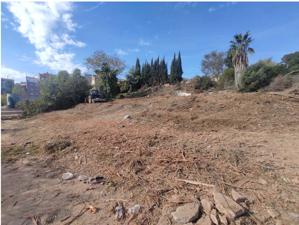
FOTOGRAFIA 8 → Vista inicial del les tasques de desbrossat dels terrenys, previs als moviments de terres, des del sud-est.
